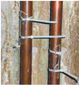
La forme de ces plaquettes équilibrantes est conçue pour annuler l'effet négatif des tuyaux dont le cuivre peut être lessivé par une eau acide.
